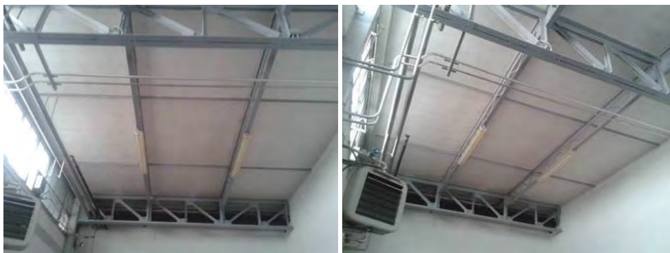
RISTRUTTURAZIONE E RIQUALIFICAZIONE DEGLI SPOGLIATOI PRESSO FAB. 14 DI CASELLE NORD DELLO STABILIMENTO ALENIA AERMACCHI
