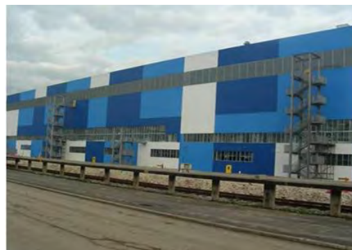
STABILIMENTO FIAT S.P.A. DI CASSINO. NUOVI FABBRICATI VERNICIATURA
