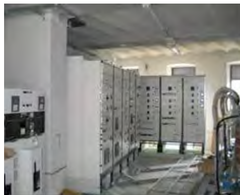
Cabina elettrica di trasformazione – fabbricato G
