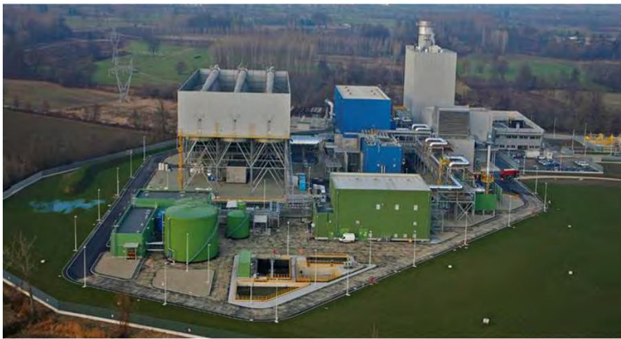
CENTRALE TERMOELETTRICA A CICLO COMBINATO DA 380 MWE - LEINÌ (TO)
