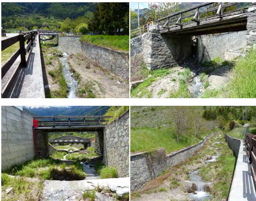
INTERVENTI DI COMPLETAMENTO DELLA SISTEMAZIONE IDRAULICA DEL RIO GERONDA COMUNE DI SALBERTRAND
